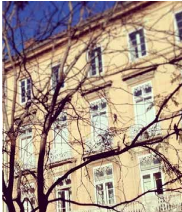
Façade du 1 place de la Bourse, Toulouse
